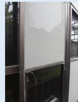
張替え前網戸(一部)
