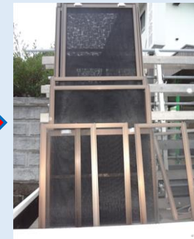
修繕・張替え後の網戸
