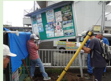
8月21日 3丁目掲示板移設作業実施
